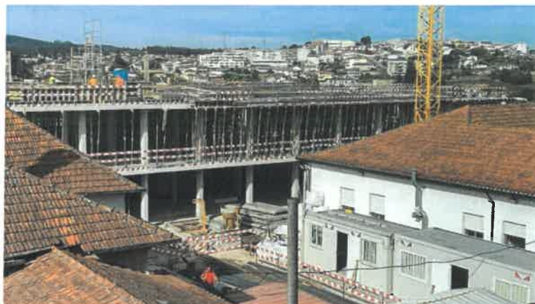
Foto 7: Obras da unidade de apoio ao SU e CSP na área da saúde mental
